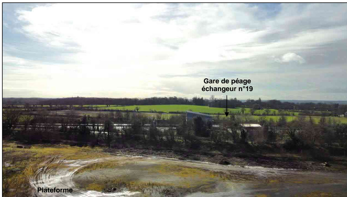
Figure 24 : Vue à 13 m de hauteur vers le sud-est de la plateforme
