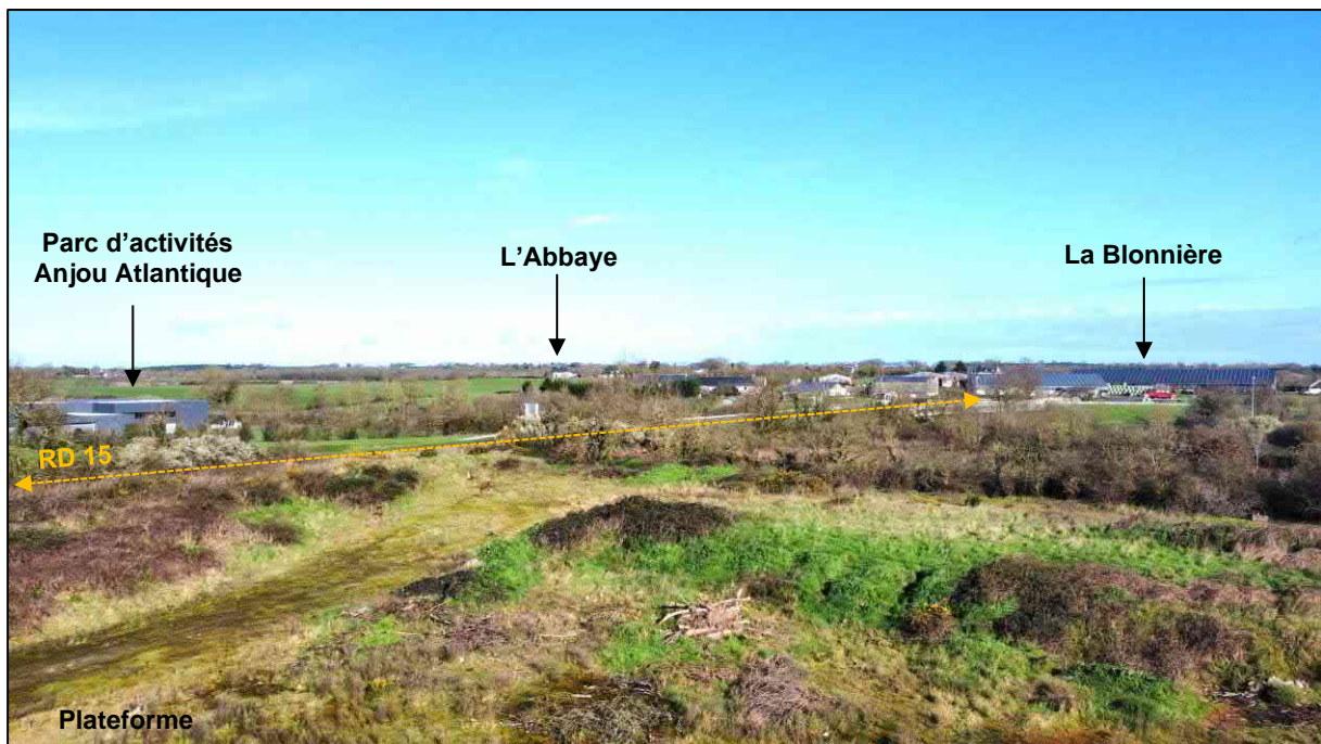
Figure 21 : Vue à 13 m de hauteur vers le nord-ouest de la plateforme
