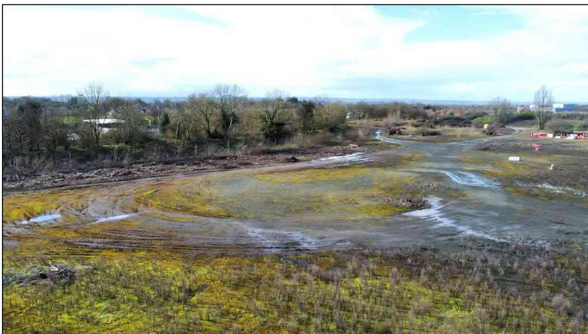
Figure 9 : Secteur sud-est de la plateforme (vue n°5)
