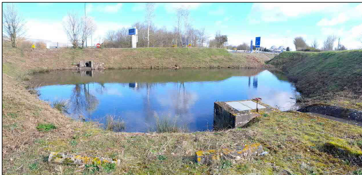
Figure 28 : Bassin de rétention hors plateforme et vanne de sectionnement manuelle (05.03.2024)
