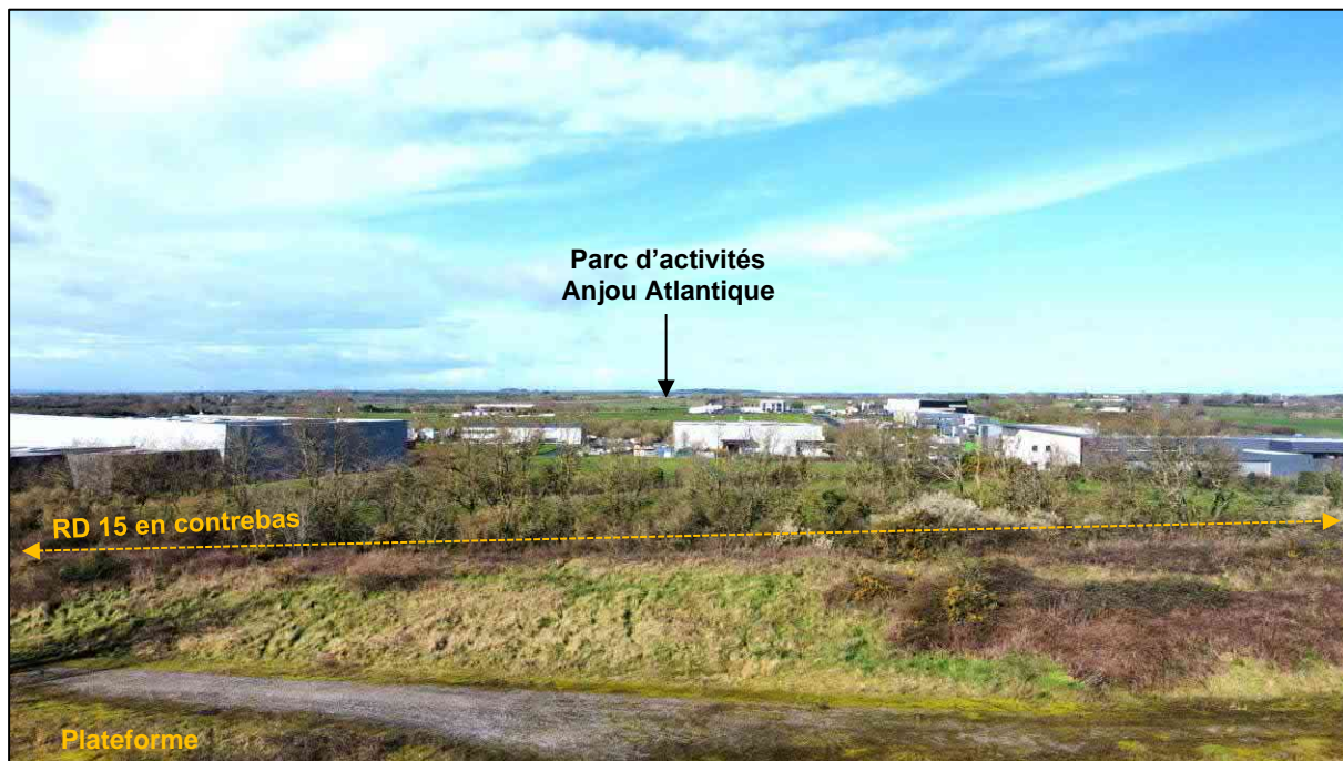
Figure 22 : Vue à 13 m de hauteur vers l'ouest de la plateforme
